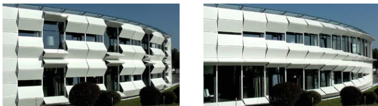
Рис. 1. Фасадные системы-жалюзи. Офисное здание, Австрия
